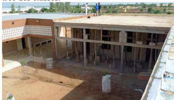
Le chantier début octobre
