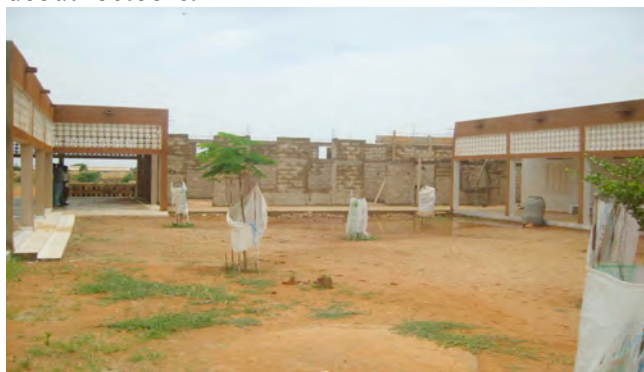
état du chantier fin août
