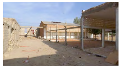
Etat du chantier en novembre 2013
